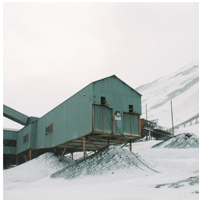
Det første møtet med Gruve 6 gående innover i den isete snøen. Rester av kull har samlet seg opp som små berg rundt lastestasjonen.
