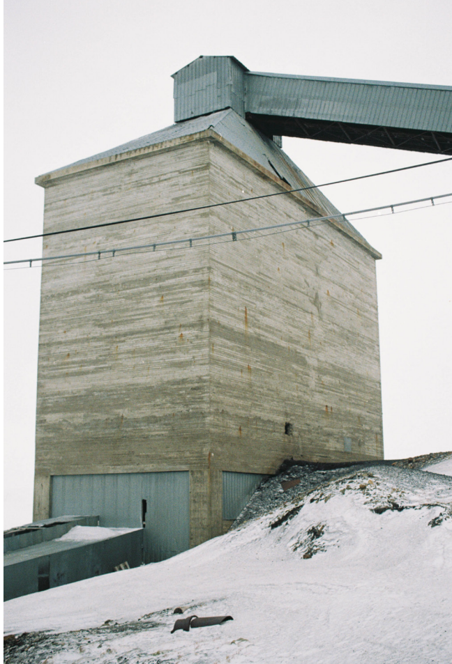
Kullsiolen i plasstøpt betong står fremdeles i god stand.
