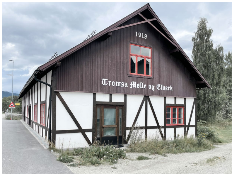
Figur 3. Bygningen hvor kraftproduksjon foregikk (Foto: Fjeldberg, I. 2022).
