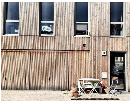
Inngangsdør/uteområde i Neue Hamburger Terrassen
